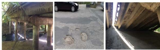
Рисунок 1 – Общий вид правой стороны моста; разрушение асфальтобетонного покрытия и защитного слоя с оголением арматурной сетки; сквозные разрушения свесов с плит пролетных строений правой стороны моста;
