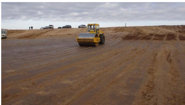
Фото 1. Уплотнение дна водохранилища.
