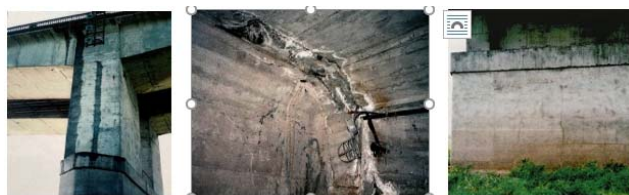
Рисунок 2 – Протечки воды, следы выщелачивания бетона; Следы протечек воды и выщелачивания бетона; Вертикальные трещины в массивной части опоры
