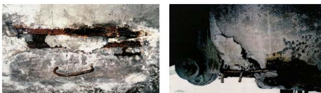
Рисунок 3 – Оголение и коррозия рабочей арматуры; Скол бетона с оголением пучка арматуры
